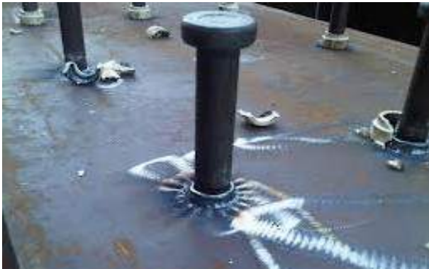
Şekil 5. Kaynaklanmış saplama fotoğrafı.
