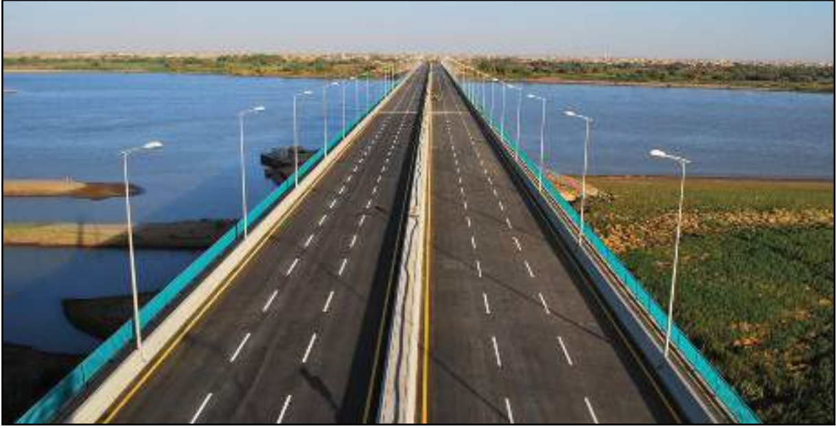
Şekil 9. Montajı tamamlanmış köprü.
