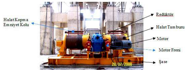
Şekil 8. Kova arabası kaldırma sistemi kaldırma grubu [10]
